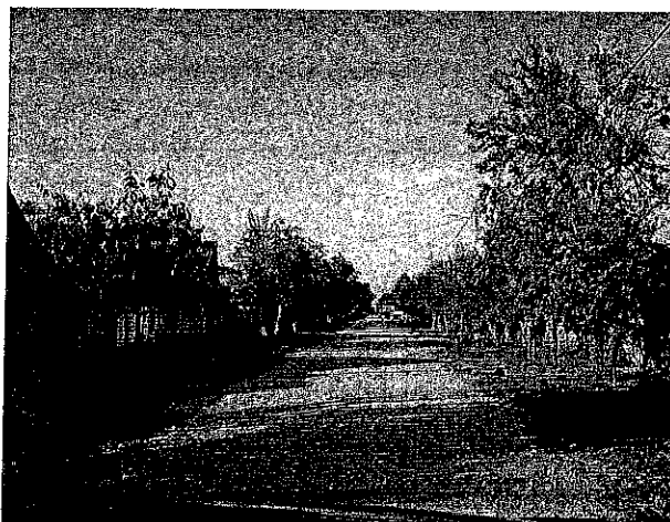
Fig. 6 . Partea carosabila pietruita a drumului judetean DJ 306 in zona localitatii Gh Doja. Se observa colmatarea sau lipsa dispozitivelor de colectare a apelor pluviale
